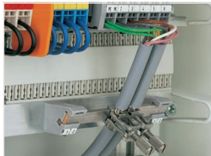
2 yalıtımlı taşıyıcı (790-100) üzerinde ortak potansiyelli ekranlama modülleri
