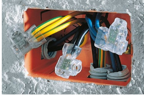
Dağıtım kutularında Z6-1, Z10-1 ve Z16-1 tipi terminallerin kullanımına örnekler
